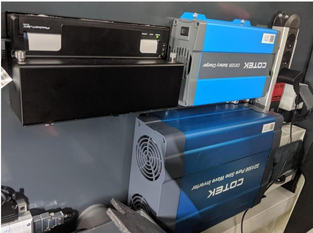
Oben rechts Batterieladegerät mit 35 A,
